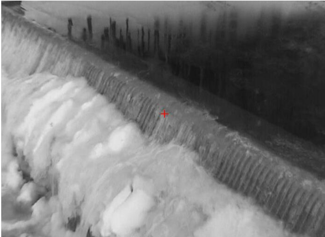
Figur 27: Coandarista tilstoppet av is (Foto: Tafjord Kraftproduksjon AS)
