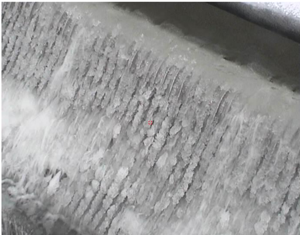
Figur 31: Gjenfryst coandarist (Foto: Tafjord Kraftproduksjon AS)
