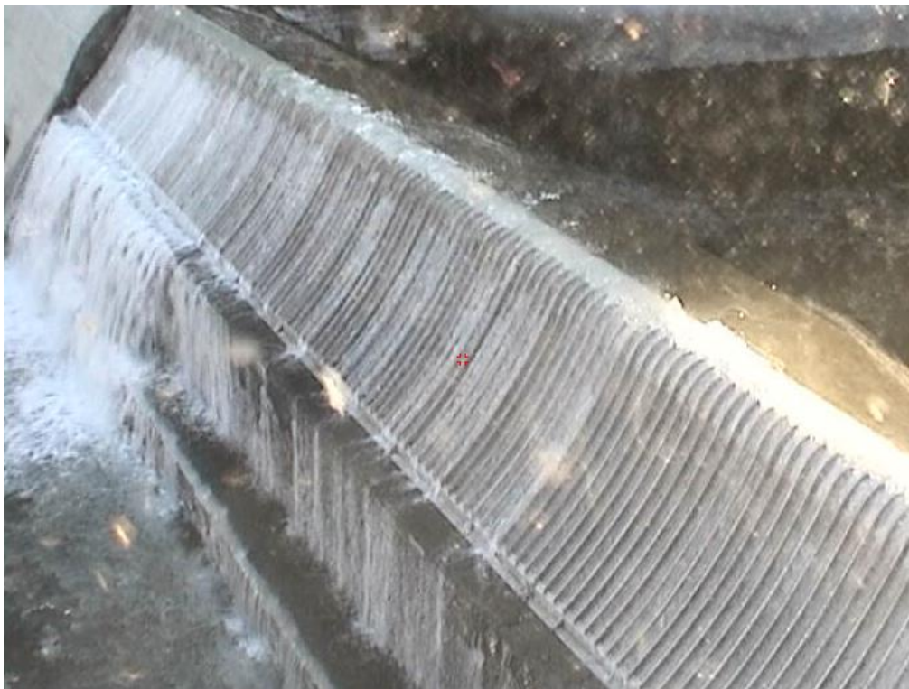
Figur 42: Coandarist delvis gjenfryst 17. april (Foto: Tafjord Kraftproduksjon AS)
