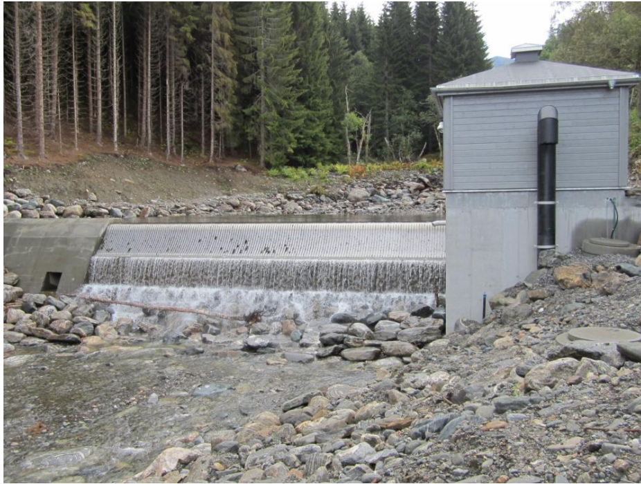
Figur 3: Coandainntak ved Dyrkorn Kraftverk (Foto: H. Opaker)
