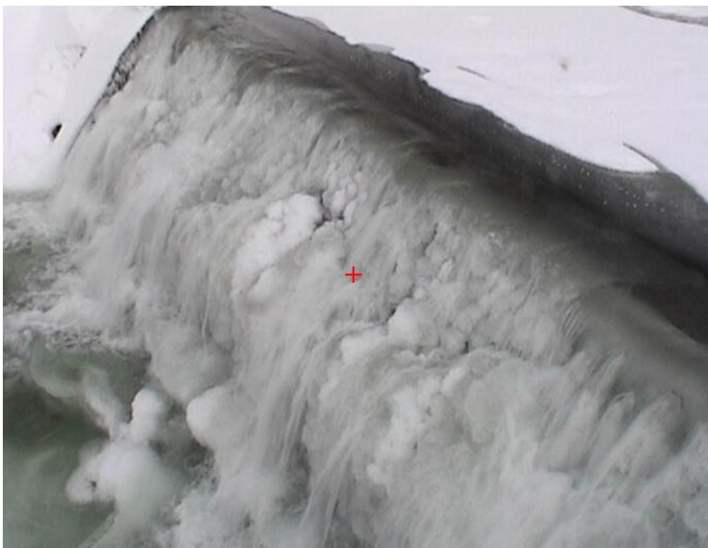
Figur 22: Gjenfrost coandarist (Foto: Tafjord Kraftproduksjon AS)
