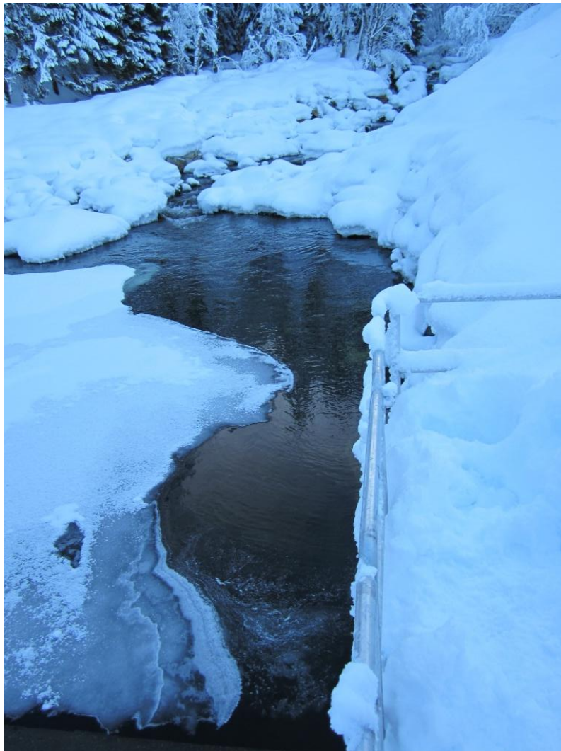
Figur 32: Åpen råk på inntaksdam (Foto: H. Opaker)
