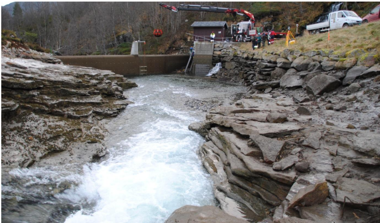
Figur 9 Inntaksmagasinet til Juvfossen kraftverk nedtappet for rensk av sedimenter i kanal ved inntaket
