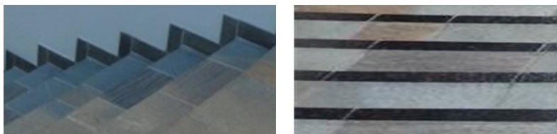
Figur 30 Trapp Høgskolen i Narvik før og etter trappenesekontrastering
