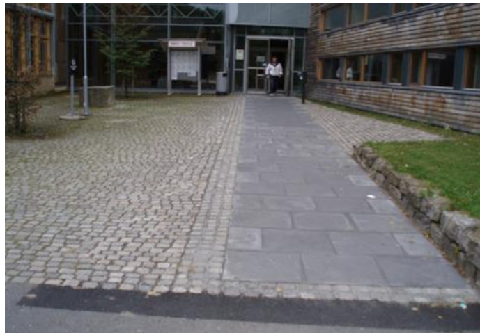
Figur 28 Hellelagt gangsti mot inngang ved Høgskolen i Lillehammer
