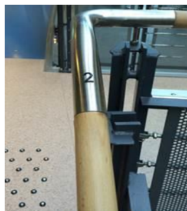
Figur 26 Trapp høgskolen i Narvik før (t.v) og etter uu-tiltak håndlist, etasjeangivelser, fare- og oppmerksomhetsfelt
