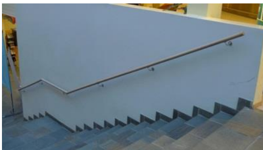
Figur 26 Trapp høgskolen i Narvik før (t.v) og etter uu-tiltak håndlist, etasjeangivelser, fare- og oppmerksomhetsfelt
