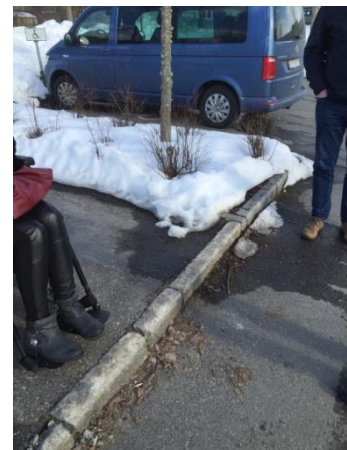
Figur 35 Gangsti til HC-parkering, med 7 cm høy kant.
