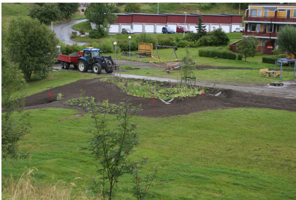
Figur A.2: Nyanlagt regnbed på Risvollan; innløp til høyre (1), overløp midt på (2) og drensutløp til venstre (3). Foto Arvid Ekle
