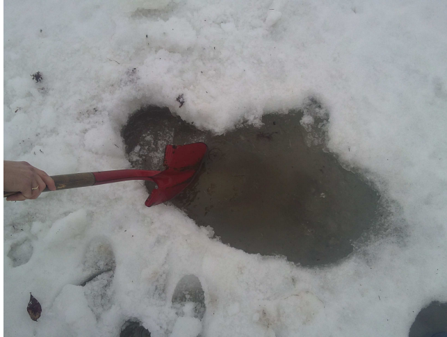
(a) Snø og sørpe i regnbed gir forskjellig vannstand ved innløp og utløp
