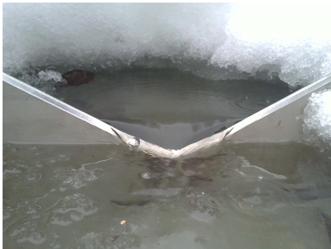
(c) Snø på innsiden og utsiden av regnbedet gir kanalstrømning i overløpet
