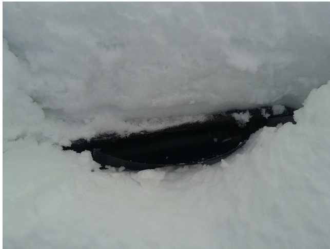
(b) Nedsnødd drensutløp
