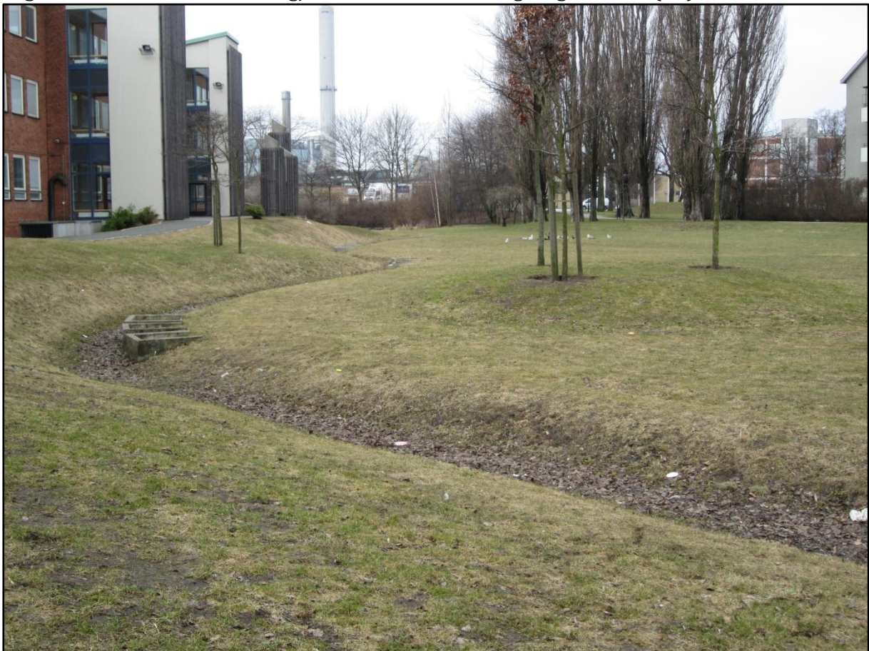
FIGUR 6 KANALER I AUGUSTENBORG 15. MARS 2012. I BAKGRUNNEN SKIMTES UTLØPET FRA BYDELEN. FOTO AV JON HUURNINK.
