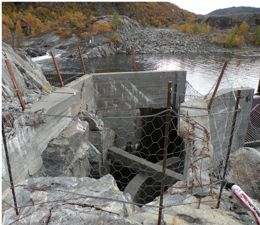
Figur 31: Toppen av sjakta på Holmaliåna, bildet er tatt i okt. 2008
