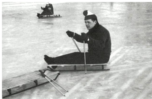
Figur 4 – De første kjelkene var vanlige trekjelker påmontert skøytestål (facebook.com/icesledgehockey)
