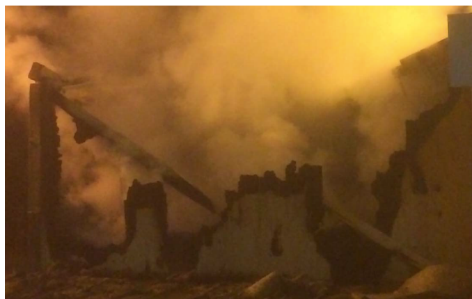
Figur 4.10: Rester av den ubeskyttede vegg i test 2 [31]
