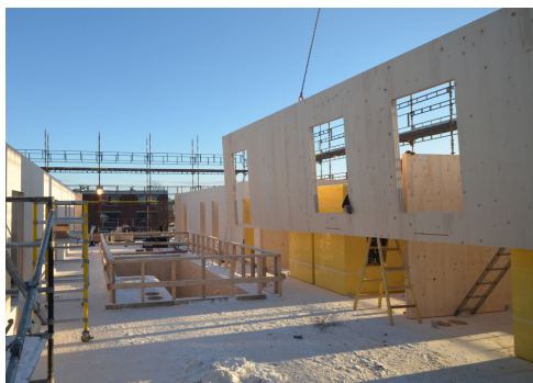
Figur 1.2: Montering av ferdige massivtreelementer på byggeplass [35]
