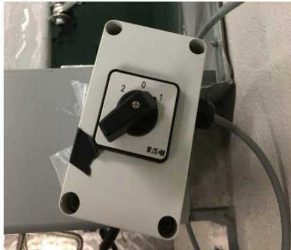
Figur 13 Bryteren som heiser sidedempere opp og ned. Posisjon 2 er senket, posisjon 1 er hevet. I posisjon 0 skjer det ingenting
