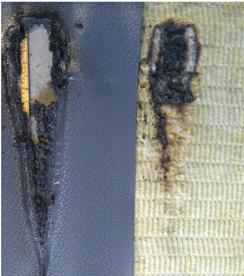
Figure 7 Skadet materiale etter endt test, Foto Eirik Smeplass
