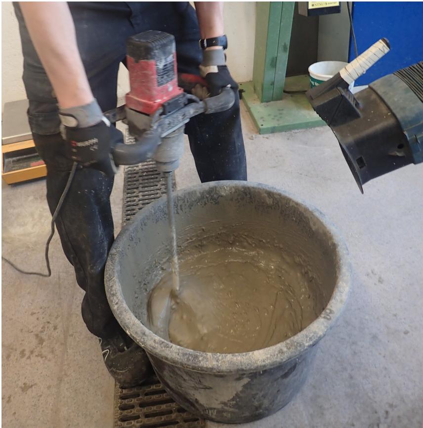
Figur 9.12: Mørtelmiksing, husk avtrekk under tilsetning av tørrmørtel.
