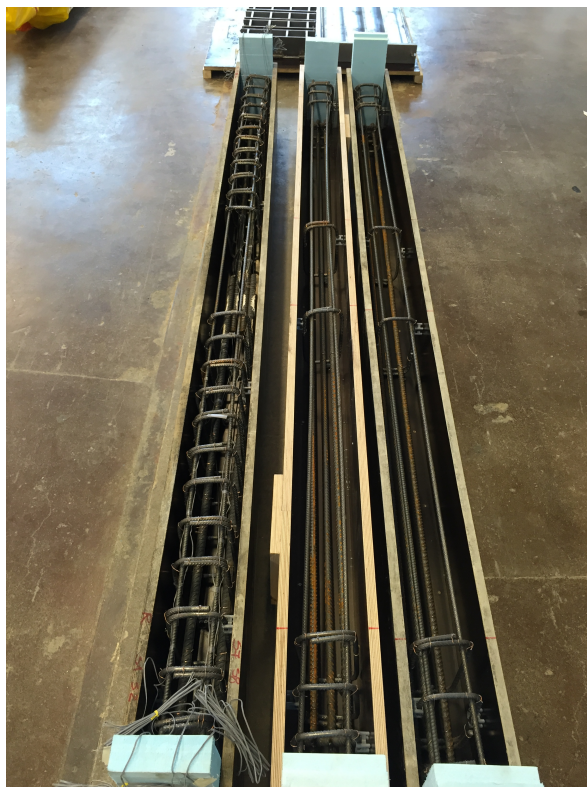
Figur A.4: Forskalingsformer med armering
