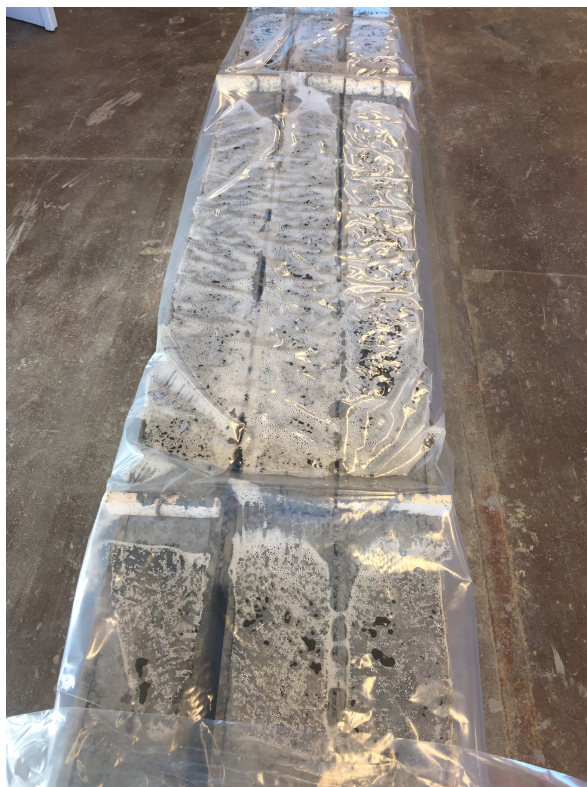
Figur A.5: Herding av betongen i dampperplastikk
