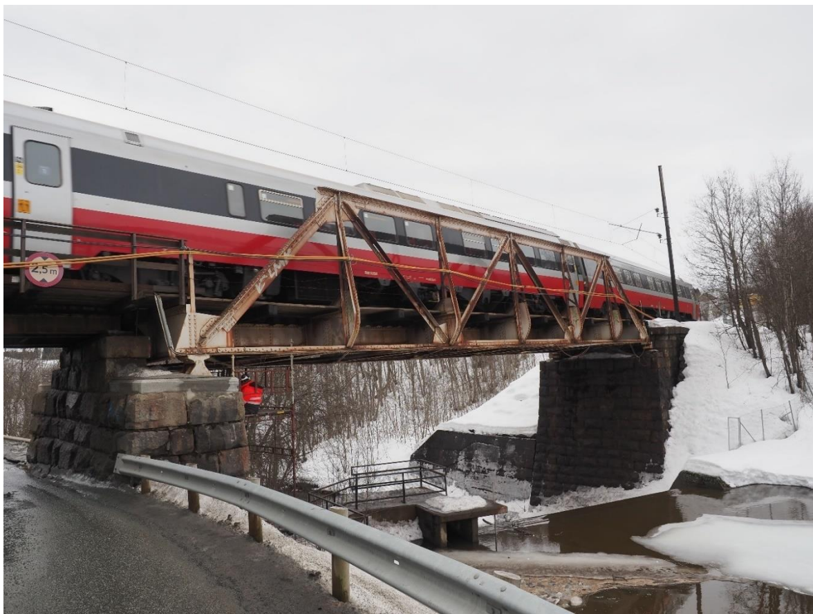
Figur 18 Togpassering over Lerelva bro
