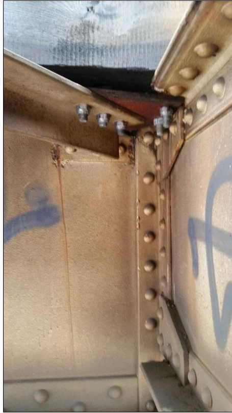
Figur 4.6 Reparert skjøteplate ved opplager
