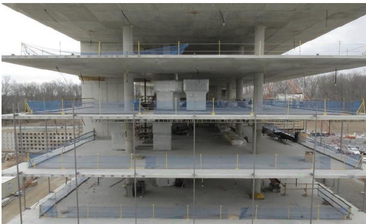
Bilde 2.20 Eksempel fleretasjes bygg med etteroppspente dekker
