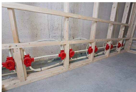
Bilde 2.14 Eksempel elektrisk skjultanlegg i bindingsverk (treverk)
