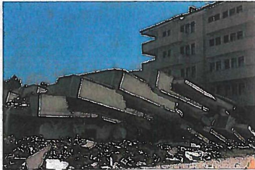
Bilde 2.9 Betongbygning kollaps ved jordskjelv
