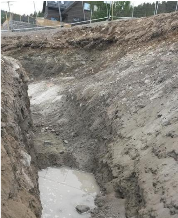
Figur 3 Fremgravd berg i fot av skråning nordvest på tomten
