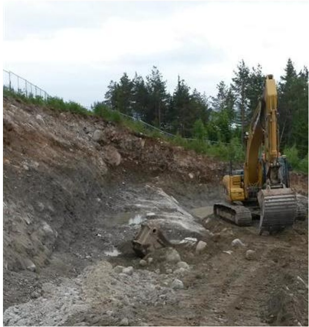
Figur 2 Fremgravd berg i fot av skråning nordøst på tomten
