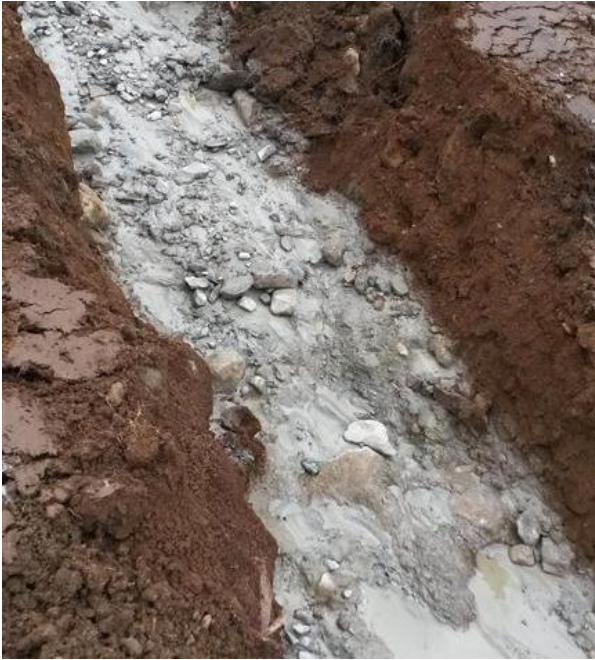
Figur 1 Humusholdige og vannømfintlige løsmasser
