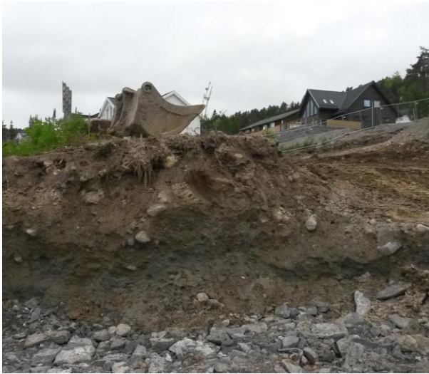
Figur 5 Lagdeling for de øvre løsmassene
