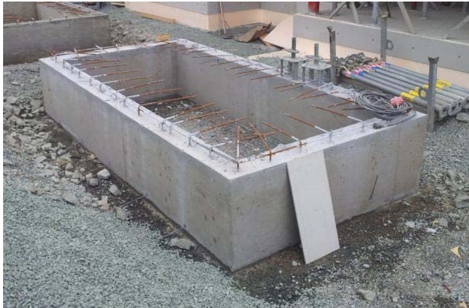
Figur 8 - Eksempel på stedstøpt betong. (8)
