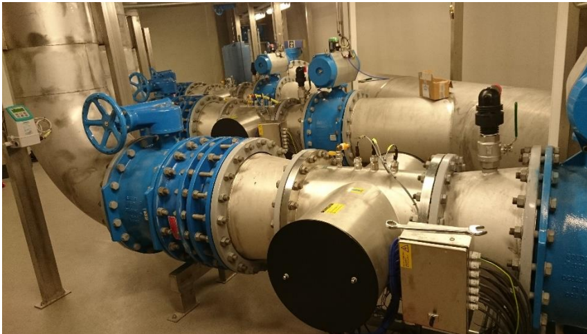
Figur 20. Foto av UV-kamrene ved Ålesund vannverk
