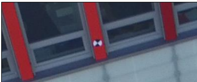
Figur 22: laser target på veggen av bygget
