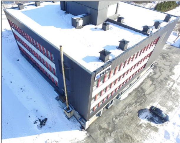
Figur 15: B bygget med snø på taket
