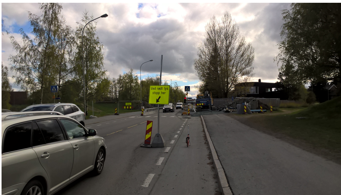
Figur 4: Anleggsarbeid Kong Øysteins veg, retning Moholt
