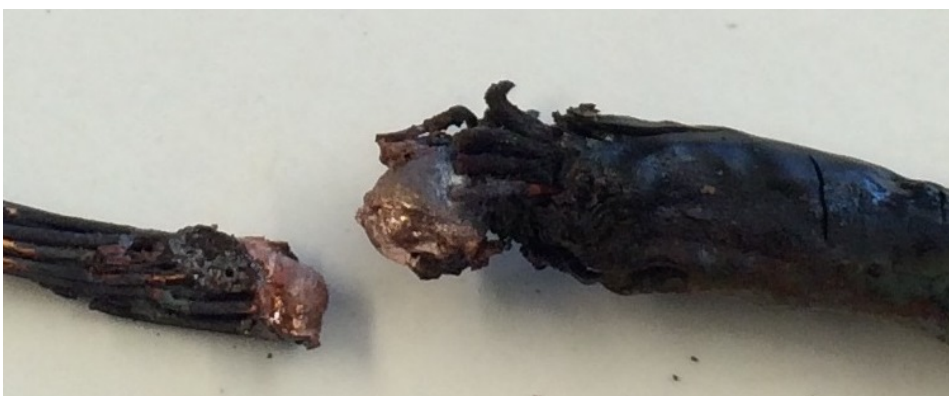
Figur 6.7: Ledningene i den dårlige kontaktforbindelsen etter at det hadde oppstått lysbue. Bildet viser tydelig at det har blitt dannet en kobberoksidbro i koblingsforbindelsen mellom lederne
