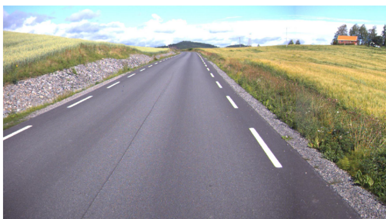
2013 Nytt dekke. Grøft forbedret og plastret.
