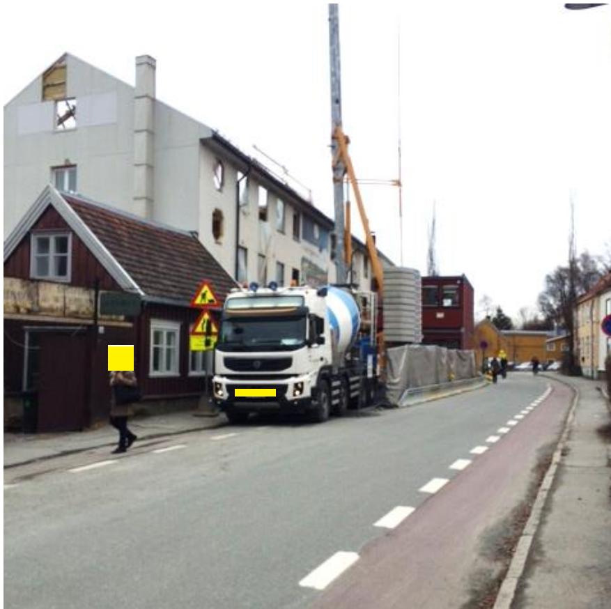
Bilde 2-1 Betongleveranse til caseprosjektet
