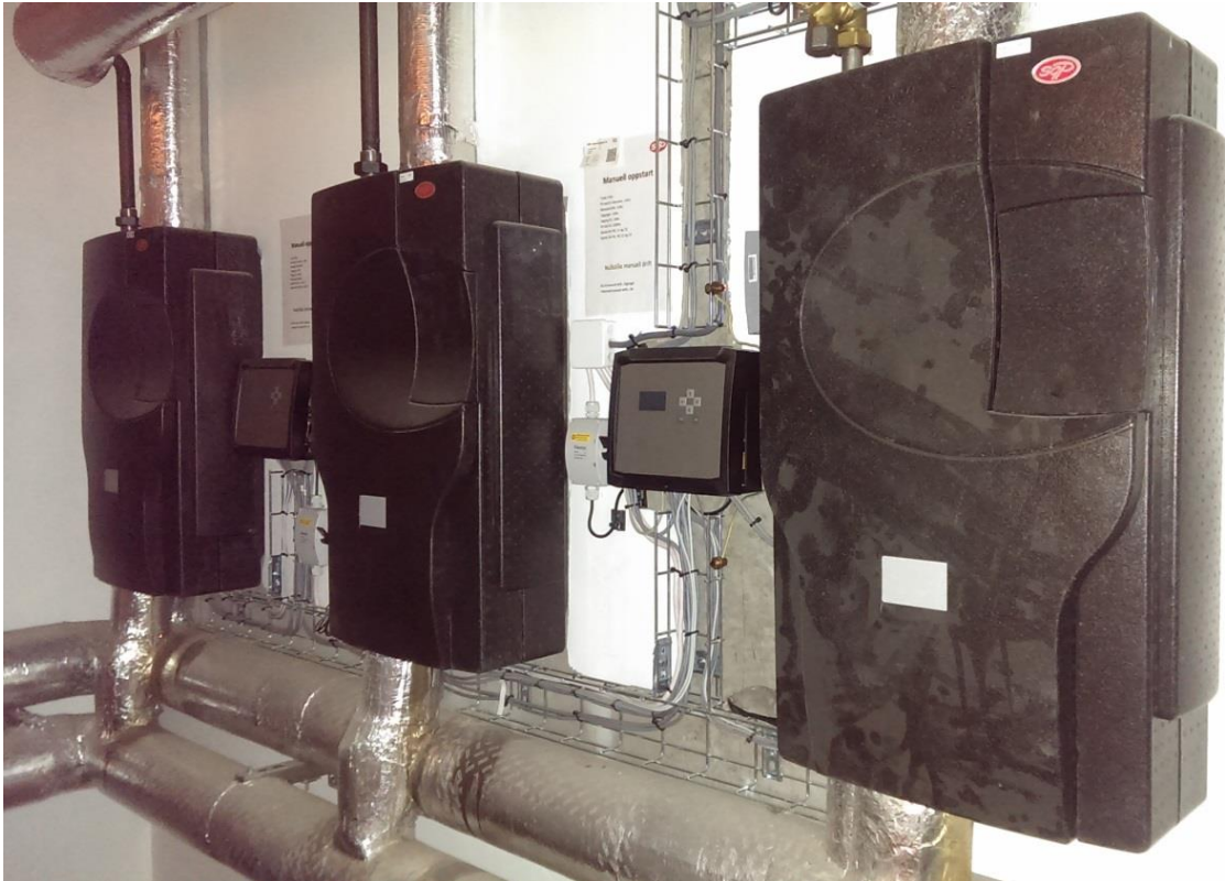
Figur 34 Bilde av soloverføringsstasjonene av typen PAW SolexMaxi.
