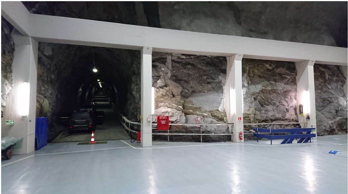
Figur 6.2: Bilde av adkomsttunnelen tatt fra kraftstasjoen.
