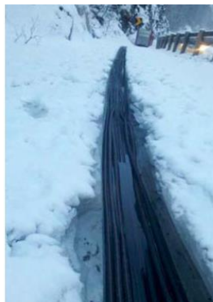
Figur 89) Varm frostvæske sirkuleres gjennom slanger og tiner en åpen kanal i isen. Foto: Karl Olav Dahlberg, Mesta (Reitan, 2013).
