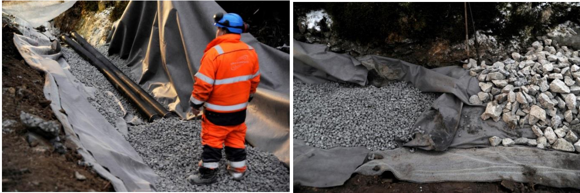
Figur 60a og b) Bygging av åpne isolerte grøfter i Tromsø. Foto fra Jan Stenersen.
