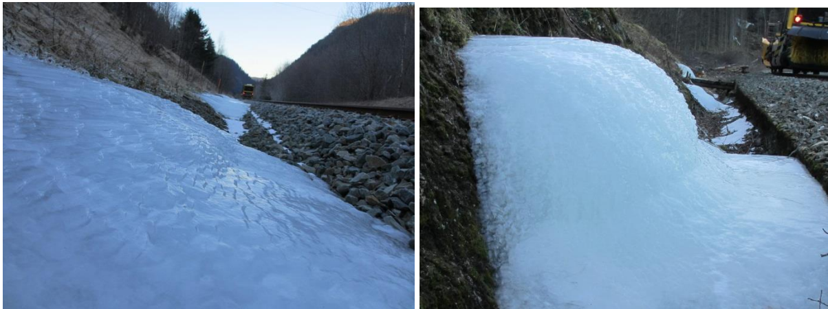
Figur 54a) Isen kan bygge seg opp til issvuller med horisontale lag. b) Når helningen på issvullen blir nær vertikal, kan isen vokse i bølgete overflate. Meråkerbanen. Foto: A. Liereng.
