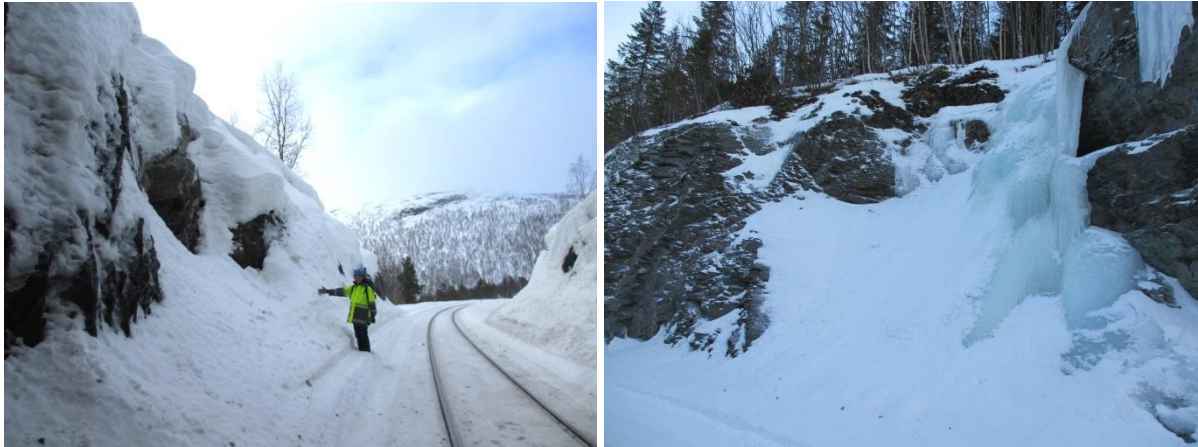
Figur 72a) Isnisje utenfor Hjartåsen tunnel (Nordlandsbanen) reduserer mengden is inn i skinnegangen. Foto: A. Liereng (15.3.16). b) Isnisje i Teveldalen (Meråkerbanen) reduserer problemene med is inn i profilet for togene. Foto: A. Liereng (19.2.16).
