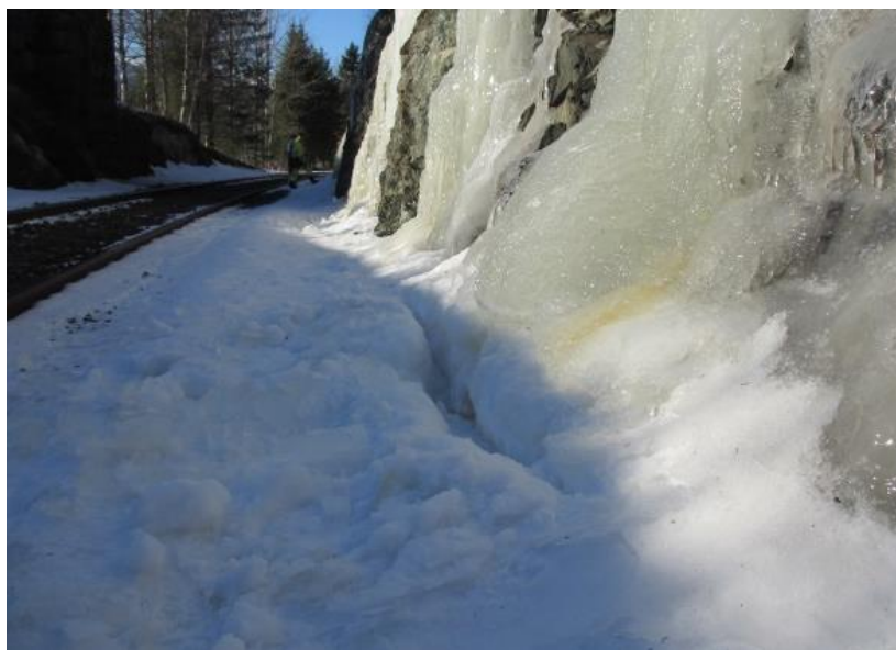
Figur 87) Det er laget en åpen kanal med ishakke for å lede vannet ned i bunnen av grøfta. Foto: A. Liereng (19.2.16).
