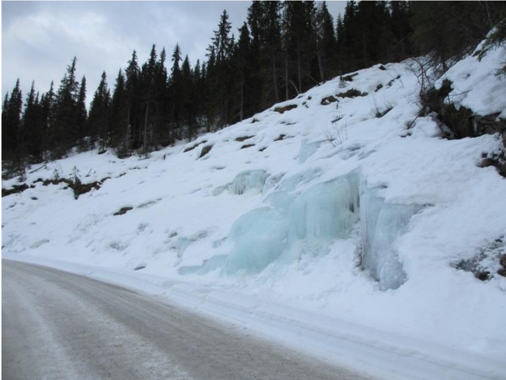
Figur V- 44) Tidligere var det ikke is her, men etter skredet har det vært mye is enkelte vintre. Foto: A. Liereng (26.3.16).
