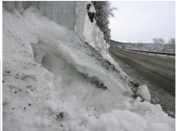
Figur V- 58a) Grøfta er smal og grunn. Foto: A. Liereng (6.11.15) b) Isen legger seg som et lokk over snøen i grøfta. Dette fører vann og is ut i vegbanen, selv om grøfta ikke er fylt av is fra bunnen. Foto: A. Liereng (25.1.16).
