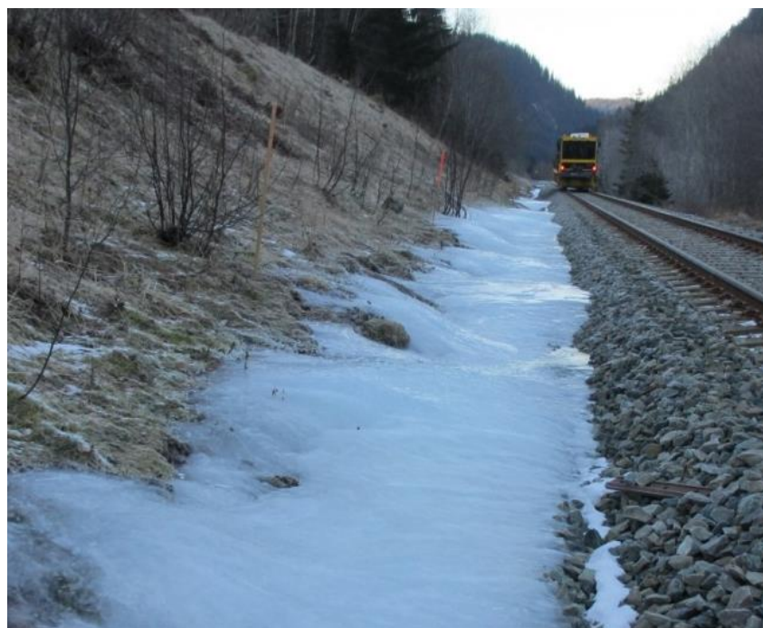
Figur V- 18) Samme strekning som forrige bilde, men sett motsatt vei. Legg merke til at isen begynner i akkurat samme høyde som der grunnvannet renner ut. Foto: A. Liereng (15.1.16).
