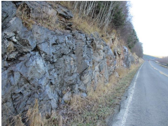
Figur V- 58a) Grøfta er smal og grunn. Foto: A. Liereng (6.11.15) b) Isen legger seg som et lokk over snøen i grøfta. Dette fører vann og is ut i vegbanen, selv om grøfta ikke er fylt av is fra bunnen. Foto: A. Liereng (25.1.16).
