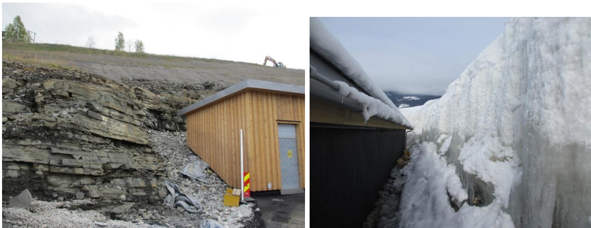
Figur V- 72a) Det tekniske bygget, sett mot sørøst. Foto: A. Liereng (19.5.16). b) Iskjøving bak bygget. Foto: A. Liereng (11.3.16).
