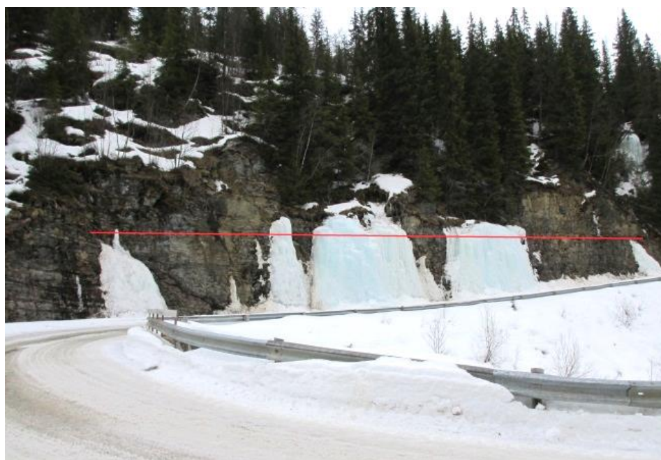
Figur V- 52a) Skjæringen øst for elva er våt i flere partier. Alt vannet kommer nedenfor et bestemt nivå, se den røde streken. Foto: A. Liereng (20.9.15). b) Iskjøving oppstår i de våte partiene av skjæringen. De største issvullene oppstår der det renner vann fra løsmassene. Foto: A. Liereng (26.3.16).
