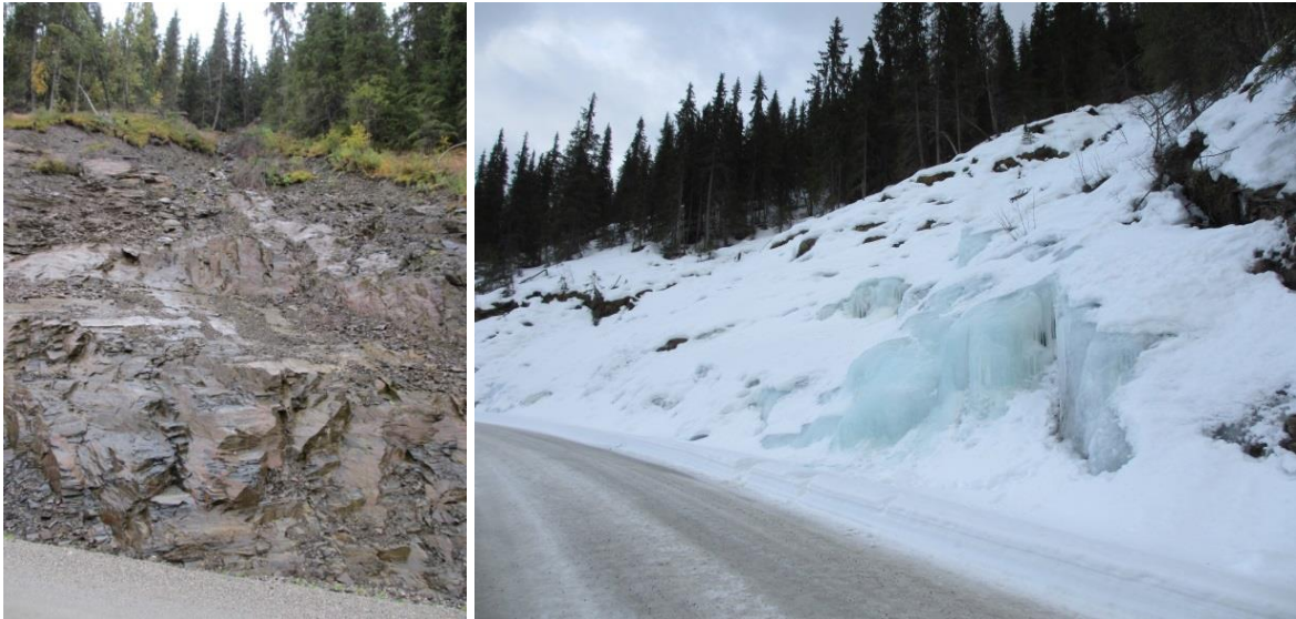
Figur 33a) Dalsiden ovenfor Tann-Annolsetervegen i Breidalen er ryddet for jord og løsmasser etter et jordskred. b) Dette øker varmetapet for grunnvannet i området og forårsaker iskjøving. Foto: A. Liereng (20.9.15 og 26.3.16).
