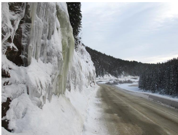
Figur V- 62) Siden avstanden mellom skjæringen og veggen er liten, kommer isen raskt i veggen for bilene. Isen kan også redusere sikten i kurven. Foto: A. Liereng (25.1.16).
