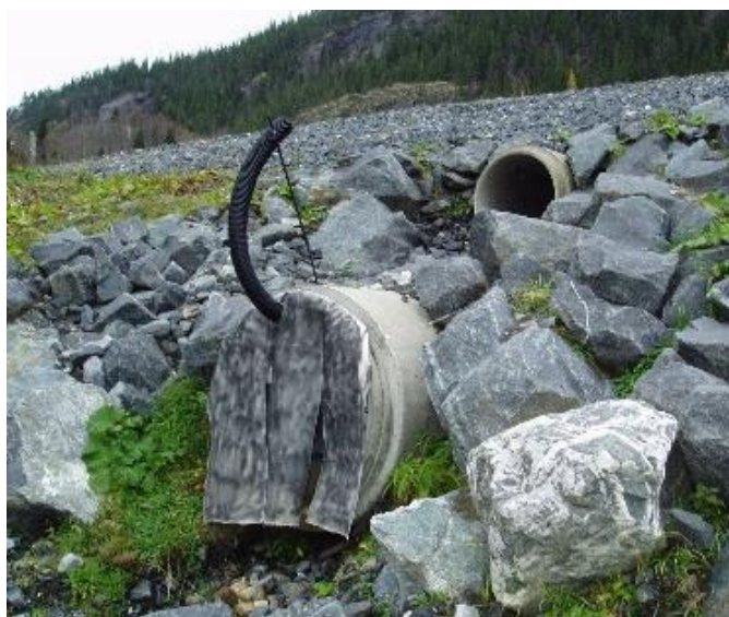
Figur 85) Tre forebyggende tiltak: Frostgardin av fiberduk for å hindre trekk, føringsrør for enkel tilkobling av dampstimplange, og ekstra stikkrenne plassert høyere i underbygningen. Nordlandsbanen, ca. km 400. Foto: Kjell Arne Skoglund
