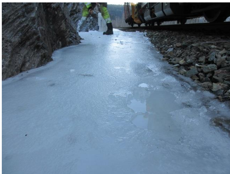
Figur 53) Iskjøving i grøft. Det er ca. 3 cm med vann over solid is. Over vannet er det en tynn isskorpe. Vannet kan dermed fryse fra både under- og oversiden. Meråkerbanen. Foto: A. Liereng.
