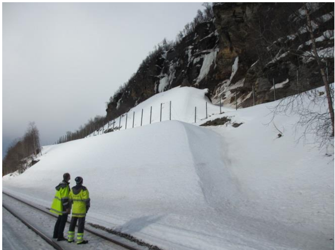
Figur 80a og b) Fjellsiden er sikret mot steinsprang og isras med voll, rasvarslingsgjerde og isnett. Raudberget, Nordlandsbanen. Foto: A. Liereng (15.3.16).
