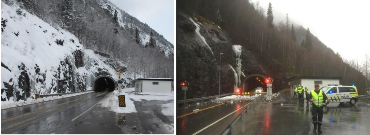
Figur 12a) Iskjøving utenfor Presturatunnelen på Fv 37. Foto: A. Liereng (3.3.16). b) 29. mars 2016 ble en bil truffet av isras på veg ut av tunnelen. Foto: Knut Heggnes (Skumvoll et al., 2016).
