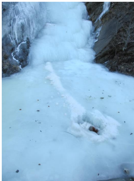
Figur 90) Det er lagt ut salt og saltstein for å smelte en åpen kanal ned til stikkrenna. Meråkerbanen. Foto: A. Liereng (15.1.16).
