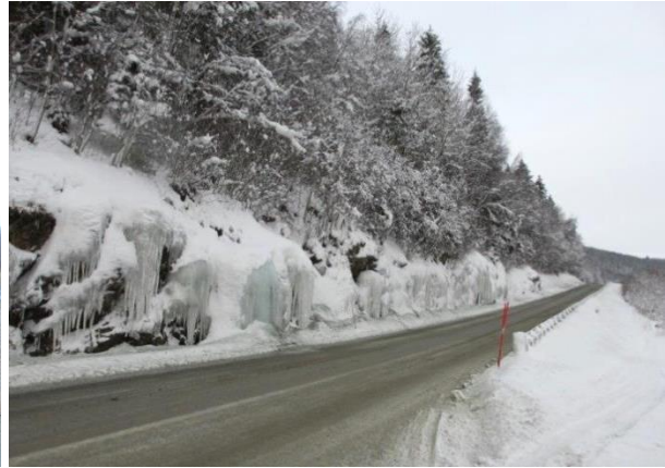
Figur V- 57a) Lav skjæring langs vegen avdekker berget. Foto: A. Liereng (6.11.15) b) Iskjøving langs hele skjæringen. Isen kommer ut i vegbanen. Det er ingen iskjøving i terrenget rundt skjæringen. Foto: A. Liereng (25.1.16).
