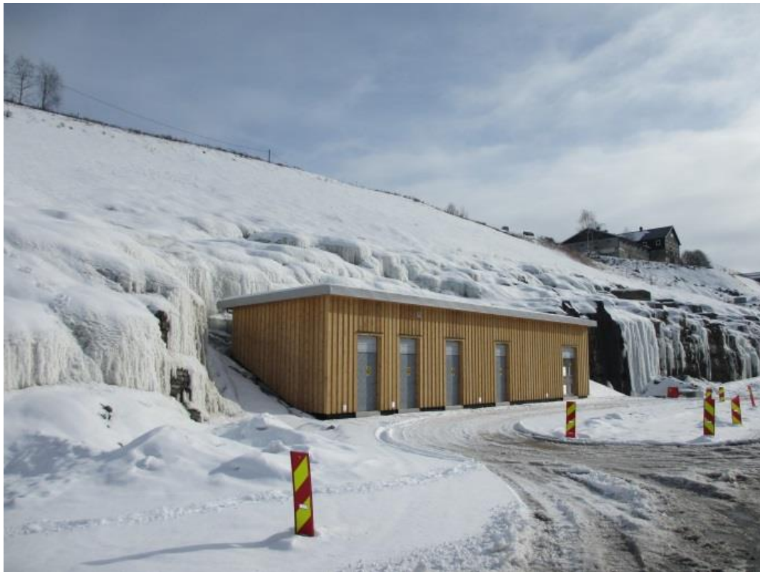
Figur 99) Iskjøving i skjæringen bak det tekniske bygget ved Odenrud. Foto: A. Liereng (11.3.16).
