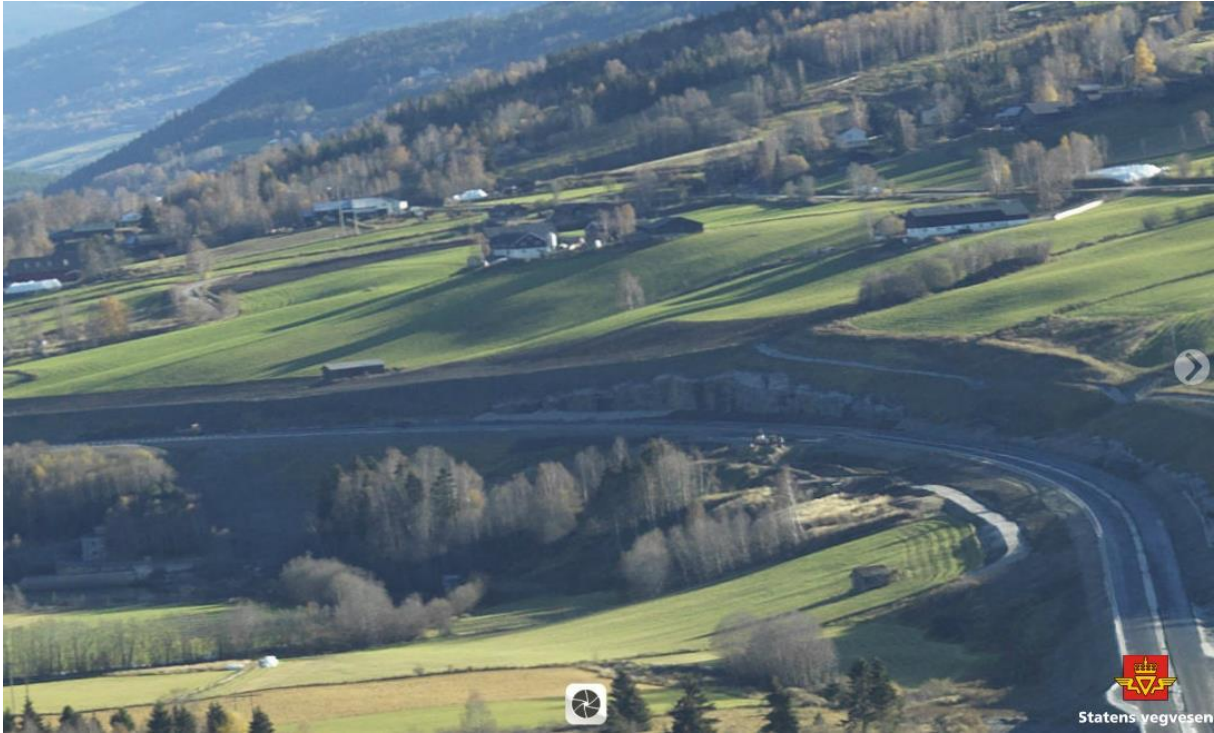
Figur V- 68) Oversiktsbilde over skjæringen ved Rudland. Ovenfor skjæringen er det dyrka mark. Foto: Arild Solberg (Statens vegvesen, 2016a).
