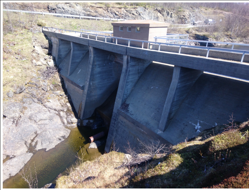
Figur 1.5: Oversiktsbilde av Stuggusjødammen, sett fra nedstrøms side.
