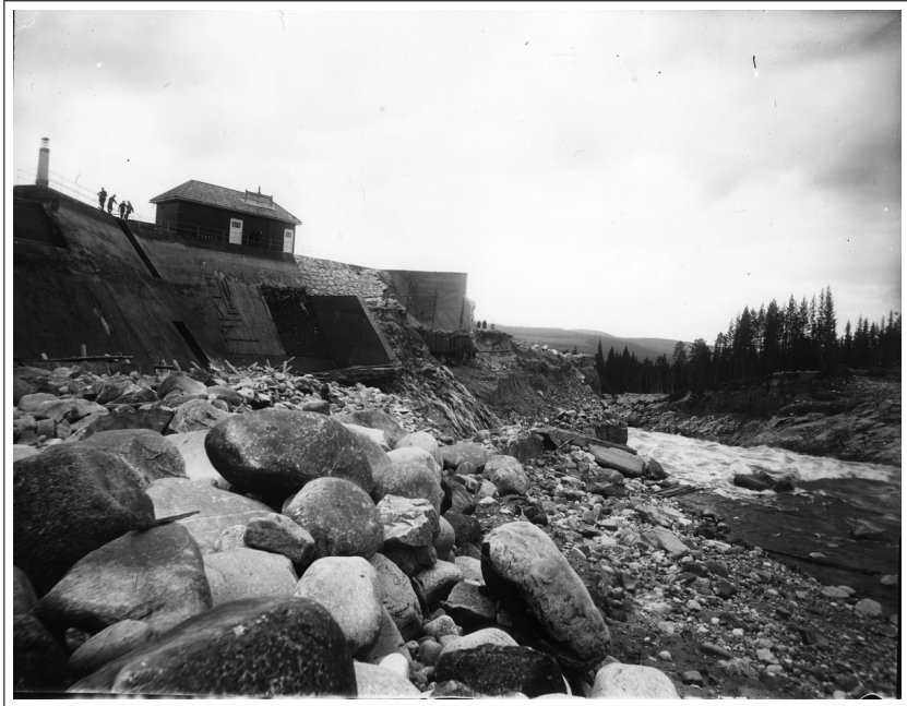
Figur 5.1: Fotografi av erosjonsskadene under damfundamentet ved dambruddet i Osfallet i 1916. Foto: Martha Alme, Glomdalsmuseet. Fotografiet er tilgjengelig fra http://digitaltmuseum.no/021015520814 under en Creative Commons Attribution-Noncommercial-lisens.
