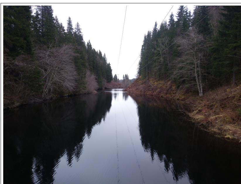
Figur F.1: Oppstrøms forhold ved Liadammen, sett i motstrøms retning fra Liadammen.
