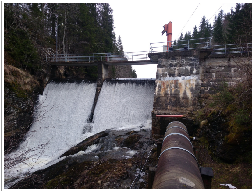
Figur 1.1: Oversiktsbilde av Liadammen, sett fra nedstrøms side.
