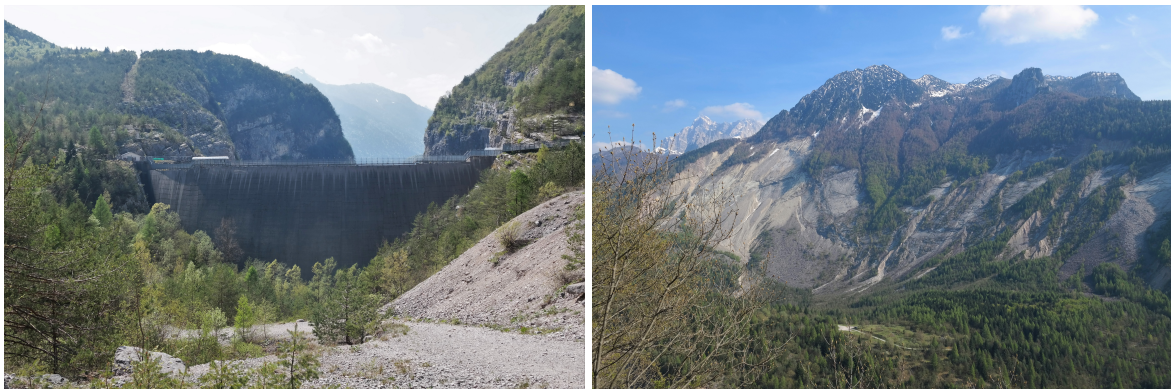
(a) Dammen stt fra oppstrøms side
