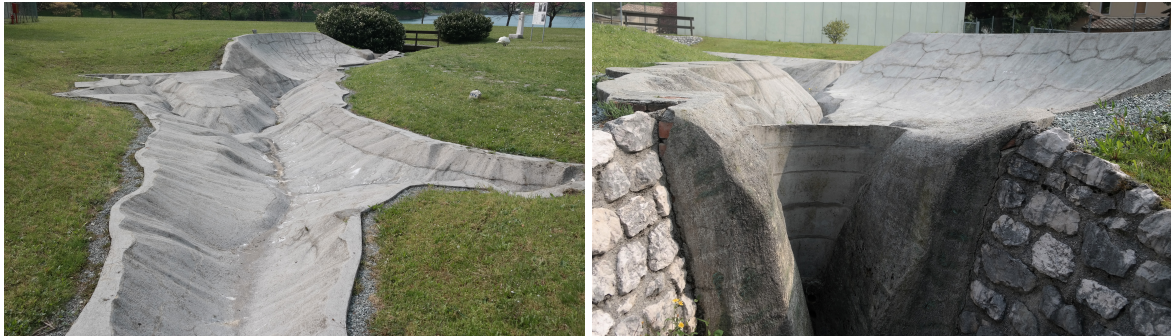
(a) Dammen sett fra nedstrøms side
