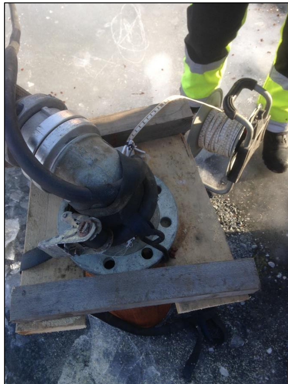
Figur 13: Måling av senkningen i brønn 5 med nedsenkbart målebånd.
