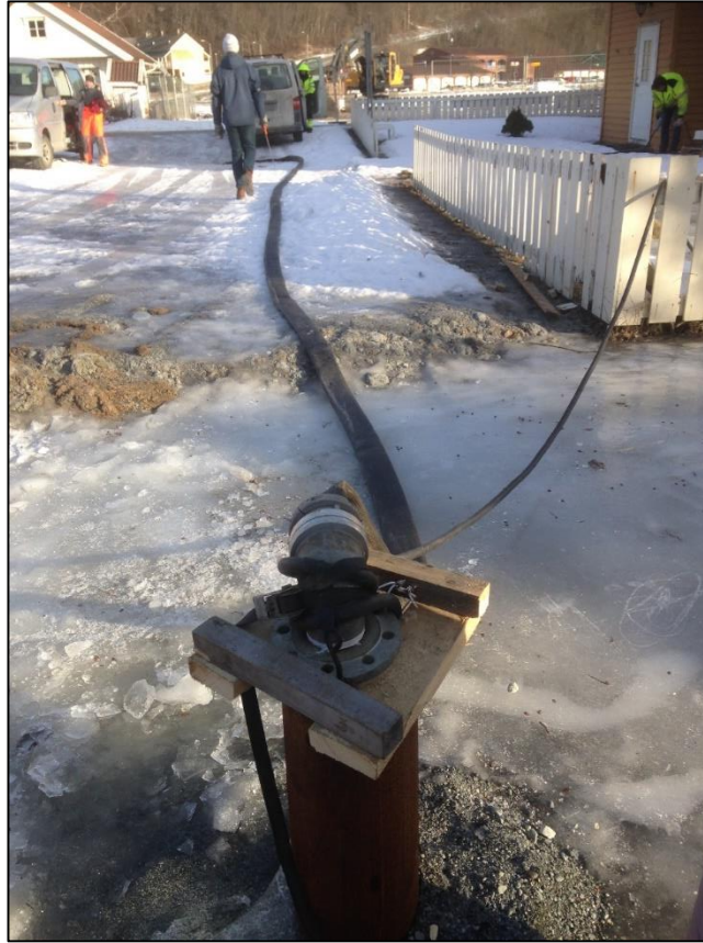
Figur 12: Oppsett av prøvepumpingen ved brønn 5. Det oppumpede grunnvannet ble spylt ut i overvannsrørene for å hindre reinfiltrasjon.
