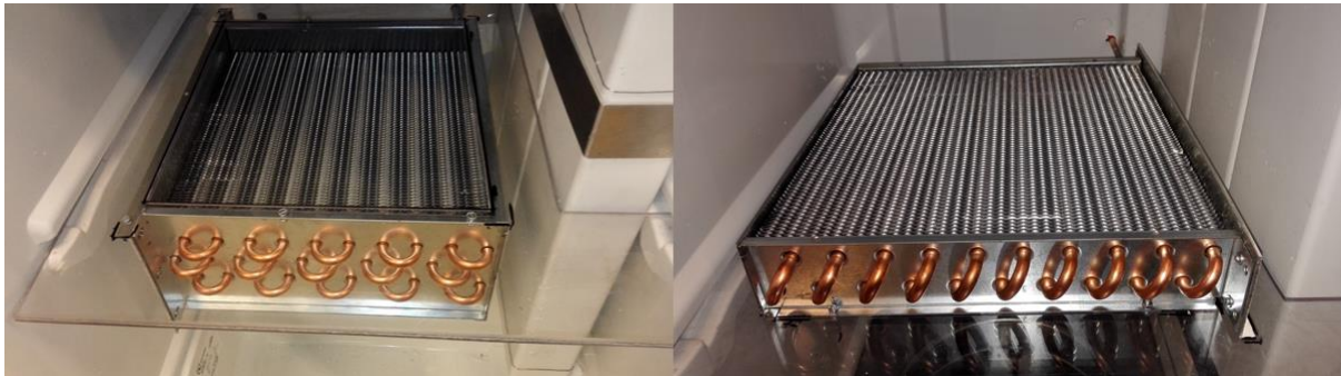
Bilde 8: Montering av innvendige varmevekslere
