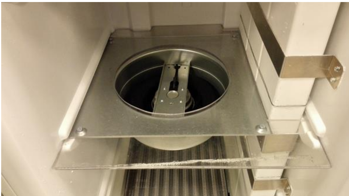
Bilde 10: Montering av sirkulasjonsvifte
