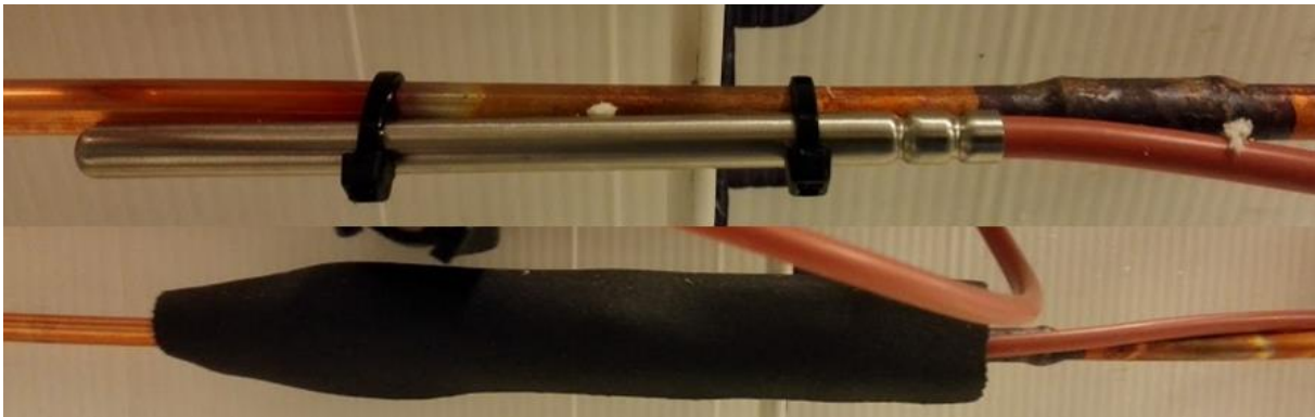
Bilde 13: Montering og isolering av temperatursensorer
