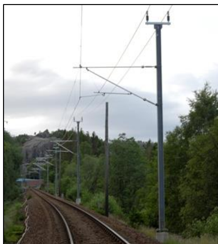
Figur 3-7 Oppheng av positiv- og negativleder [15]
