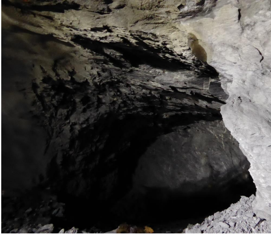
Figur 18 Fyllitten i Eiganestunnelen
