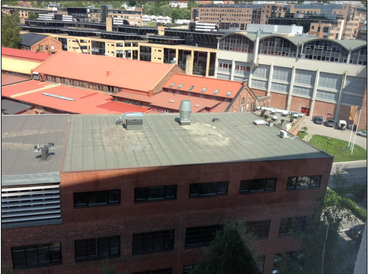
Figur 29. Nydalsveien 30B, takteking øst. Foto: Petter Martin Skjeldrum
