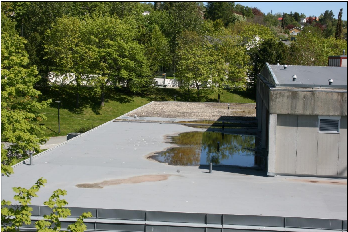
Figur 24. Bilde av taket på Høgskoleringen 7B. Mekanisk innfestet takfolie nærmest nederst i bilde, ballastert tak helt ytterst, mens annenetasjen til venstre er takfolie med "vakuum"-festing. Foto: Petter Martin Skjeldrum
