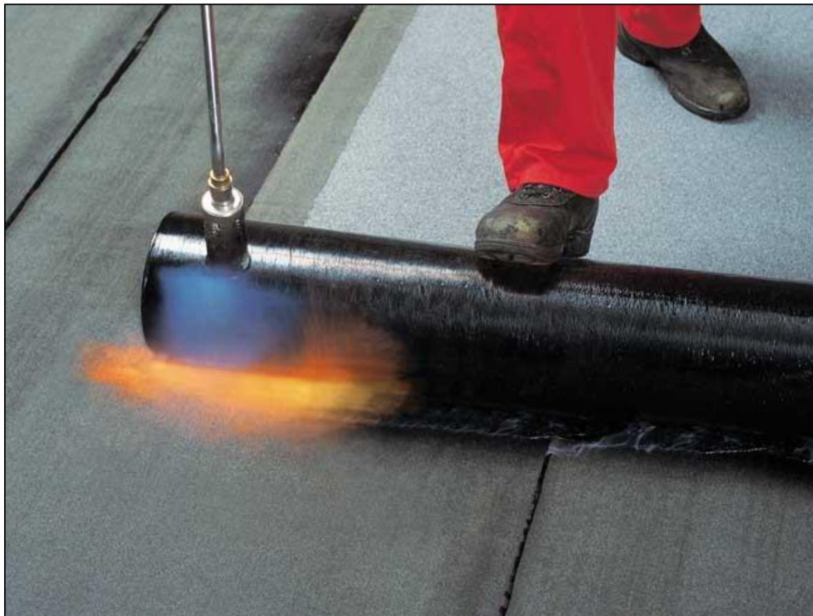
Figur 1. Asfalttakbelegg. Helsveising av overlagsbelegget til underlagsbelegget i tolagssystem. Foto: Isola
