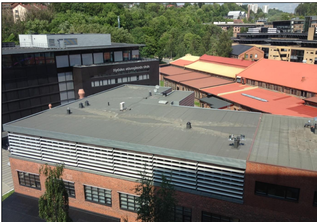
Figur 28. Nydalsveien 30 B, vestre del av taket. Foto: Petter Martin Skjeldrum
