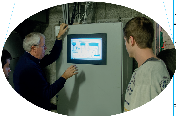
Skjermen for kretslop 2, terapibassenget, boblebadet og plaskedammen. Bjørn Aas viser noen masterstudenter hvordan touchskjermen for terapibassenget fungerer.
