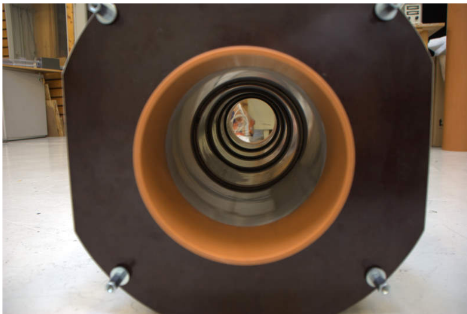
Figur 3.6: Kan tydelig se veggene stikker ut i kanalen.
