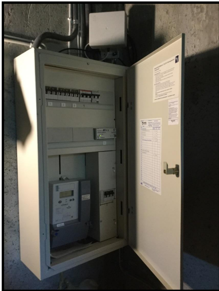
Figur 39 Hovedinntak i kjeller av bygget på Myrholt. Her står det plassert en smartmåler utlevert av NTE.
