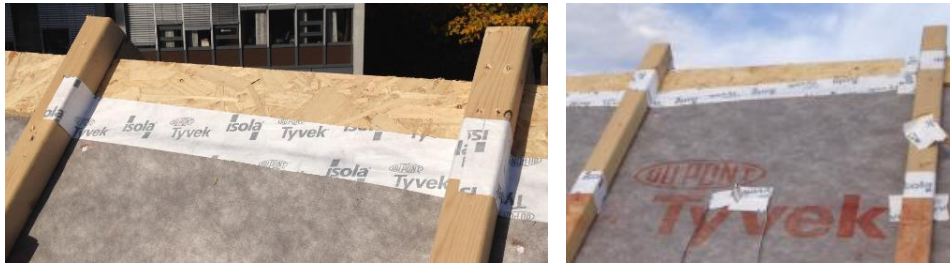
Figur 1. Oppbygning av møne, før montering av taktro. Foto: Lars Gullbrekken.
