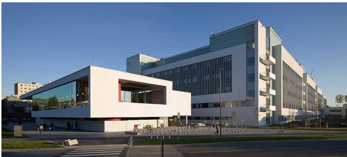
Figur 32 - Nye Ahus (Ahus, 2016b)
