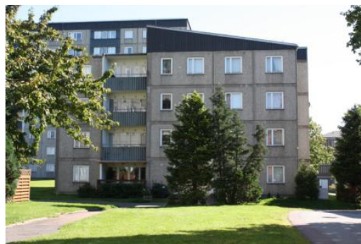
Blokka i Katjas gate 119 før oppgradering
