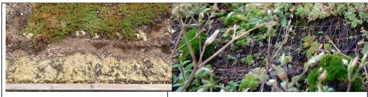
Figur 5. Detaljer skader på matter. Til venstre eksponerte Grodan matte og til høyre eksponert armeringsnett i vegetasjonsmatte.
