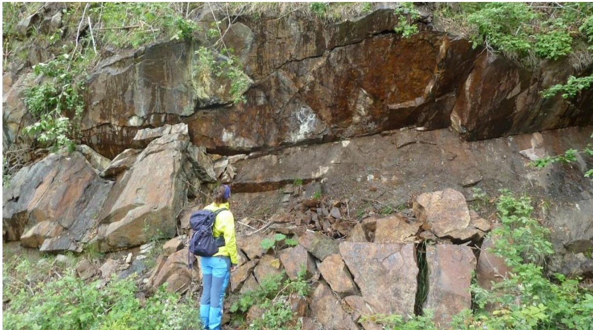
Figur 5.13: Blotning av fyllitt/glimmerskifer i vegskjæring. Flere blokker har løsnet og ligger i grøften mellom vegskjæringen og vegen. Det ene sprekkeplanet faller i dette området parallelt med skråningen. Løsmassedekket over berget er ca. 5 cm tykt. Bildet er tatt mot nordøst (Foto: Marte Bakka Stemland, 08.07.2015).
