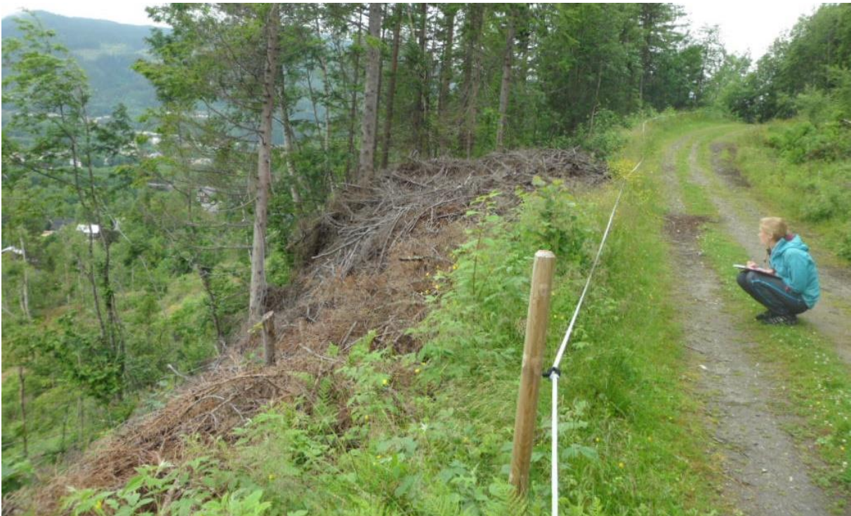
Figur 5.17: Dumping av hogstavfall utenfor skogsbilveg som har resultert i økt vekt på toppen av skråningen. Bildet er tatt mot nordvest (Foto: Marit Bakken Gjørva, 14.07.2015).
