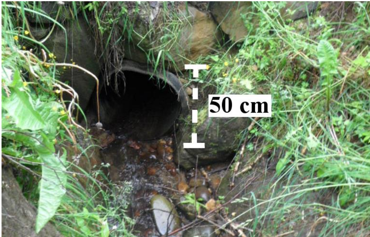
Figur 5.20: Tilstrekkelig vedlikeholdt stikkrenne i studieområdet. Stikkrennen er steinbesatt og bekken følger en 80 cm dyp forsenkning i terrenget (Foto: Marte Bakka Stemland, 14.07.2015).
