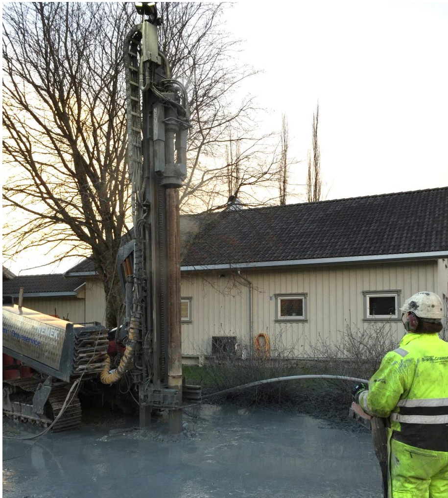
Figur 3.9. Boring av undersøkelsesbrønner. Vannet på bakken er en blanding av spylevann fra brønnen og grunnvann. Man ser også løsmassene på bakken som kom opp med spylingen av brønnen (Foto: Marit Eline Sandbakken).
