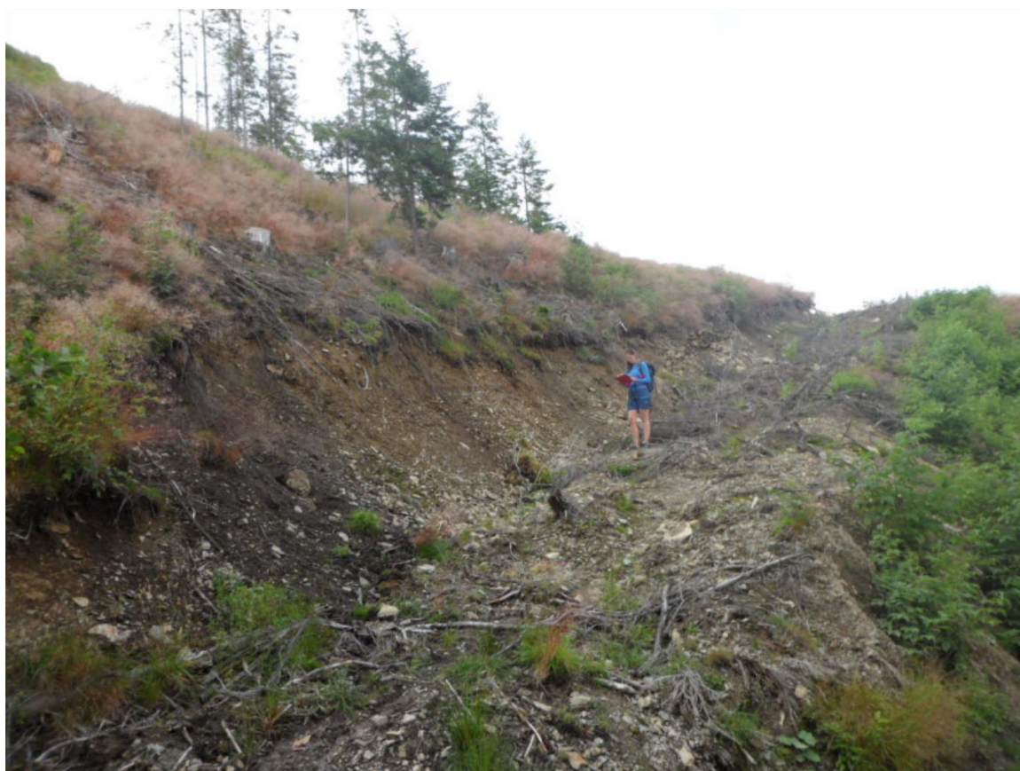
Figur 5.11. Driftsveg på Horg, med skjering i forvittringsmateriale (bilete mot nordaust) (foto: Marte Bakka Stemland (04.08.2015)).
