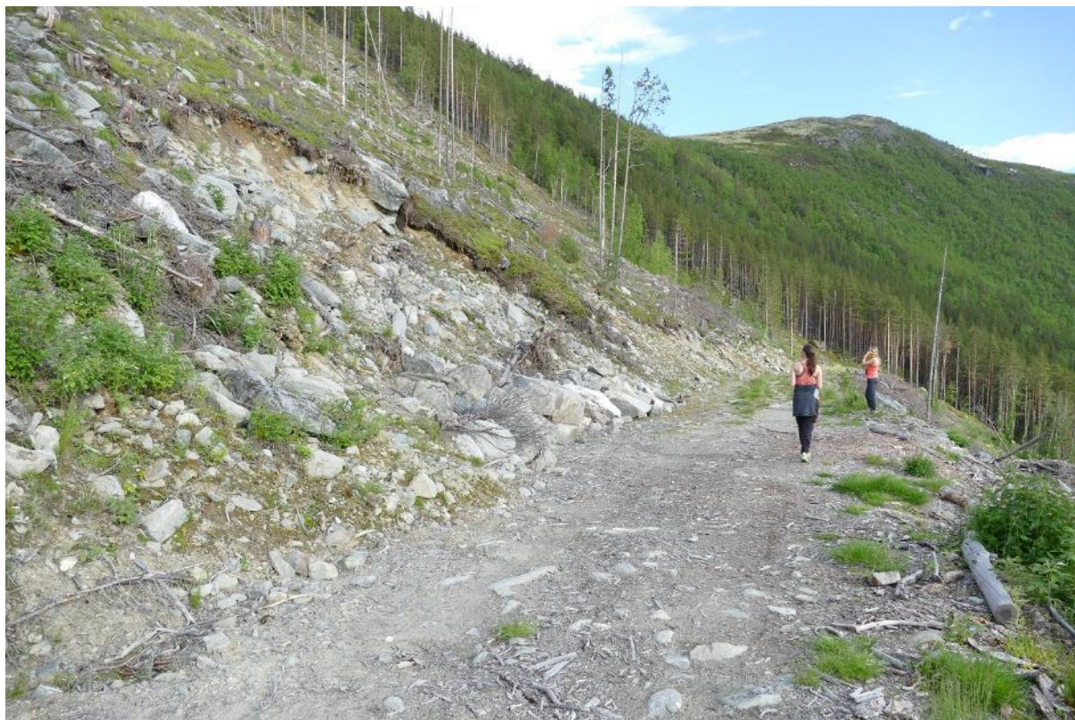
Figur 5.25. Øvste skogsbilveg i Høvringslia, her har det skjedd ei utgliding av materiale frå oversida av vegen (bilete mot sør) (foto: Terje H. Bargel (01.07.2015)).
