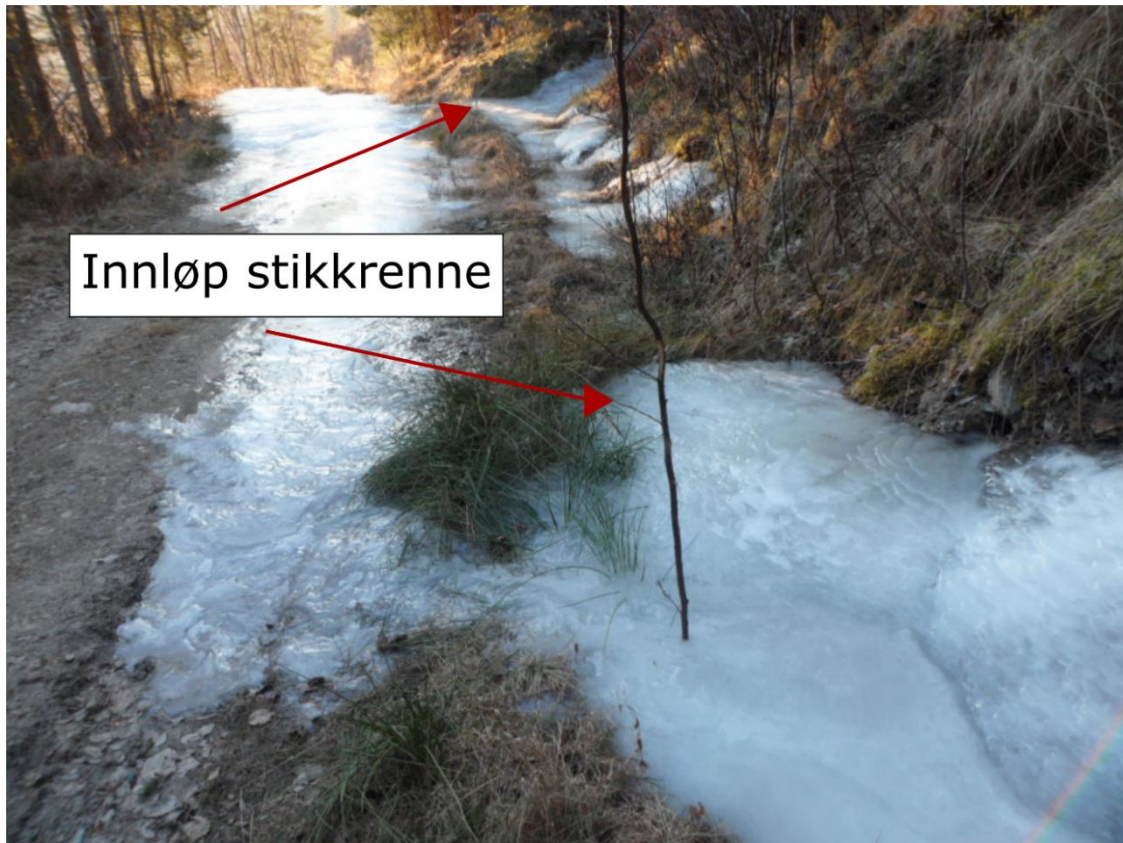
Figur 5.16. Fryst innløp til stikkrenner nr. 102 (fremst) og 103 (bakarst) (bilete mot sør) (Foto: Marit Bakken Gjørva (15.01.2016)).
