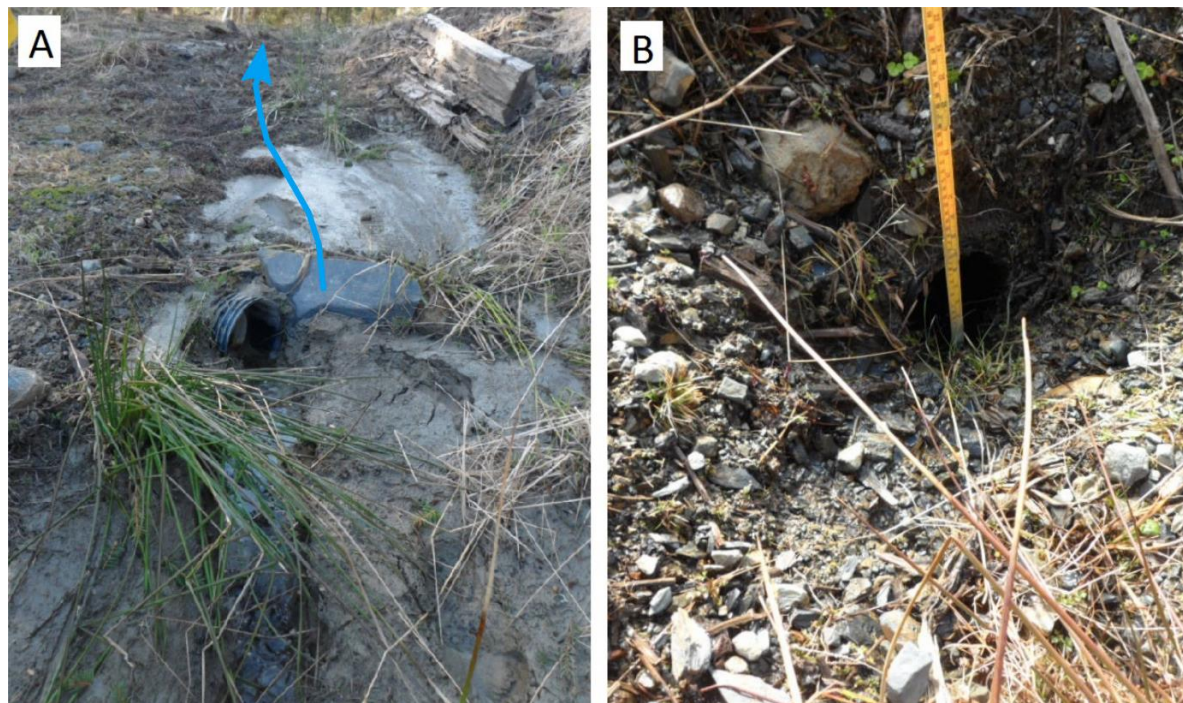
Figur 5.19. Erosjonsrenne i nedre skogsbilveg på Horg. Dei blå pilene indikerer der vatnet har fylgt vegen og erodert i vegmassane. Raud stipla linje indikerer erosjon av vegkant. Bileta er mot nordaust (foto: Marit Bakken Gjørva (18.04.2016)).
