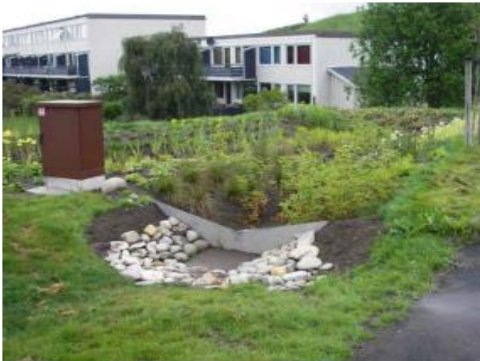
Figur 9 Regnbedet på Risvollan ferdig beplantet (Braskerud, Paus & Ekle, 2013).
