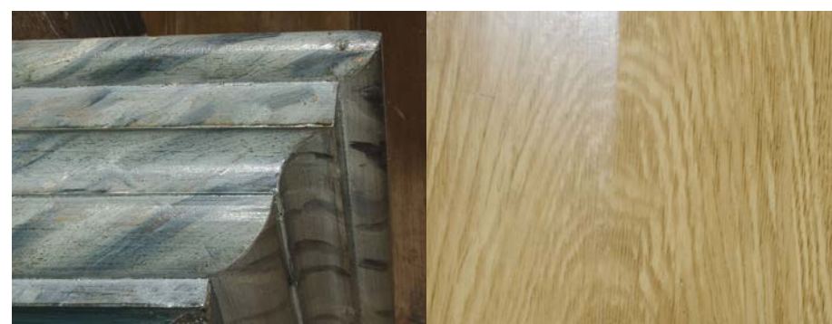
Venstre: marmorering (etterlikning av marmor). Høyre: ådring (etterlikning av tre)
