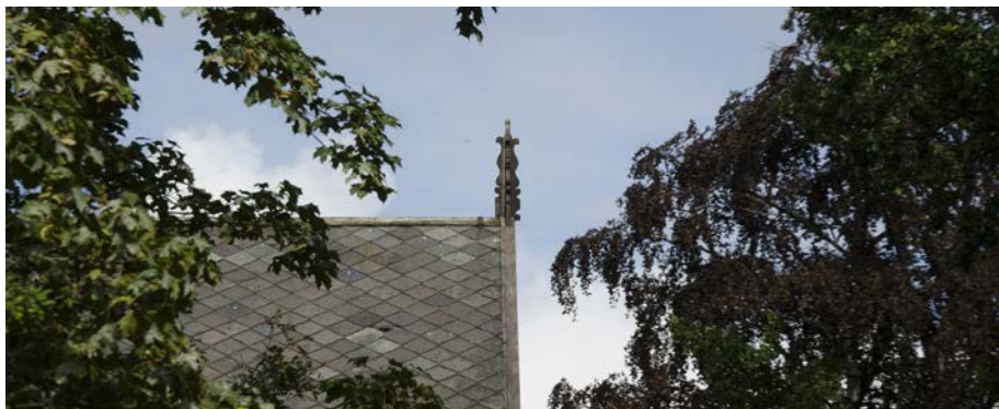
Villa Kvernbakken, Trondheim (1902). Detalj fra tak
