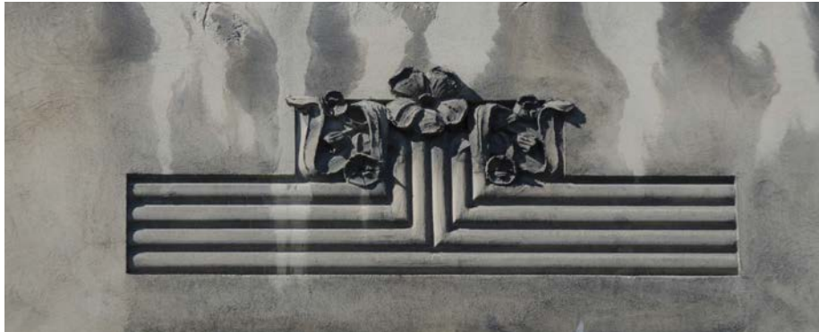
Osloveien 4-6, Trondheim (1905). Dekor overstykke, vindu.
