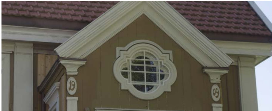
Maristuveien 5, Trondheim (1909). Dekor og vindu over inngangsparti.
