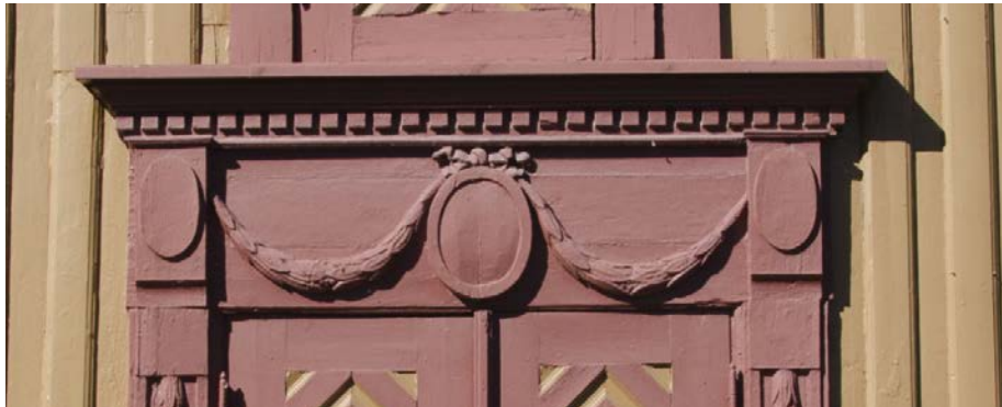
Stabbur, Lerkendal gård, Trondheim (1790). Detalj, inngangsparti.
