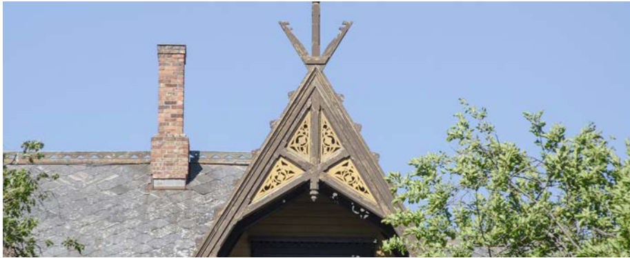
Villa Rognli, Trondheim (1881). Detalj, takutstikk.
