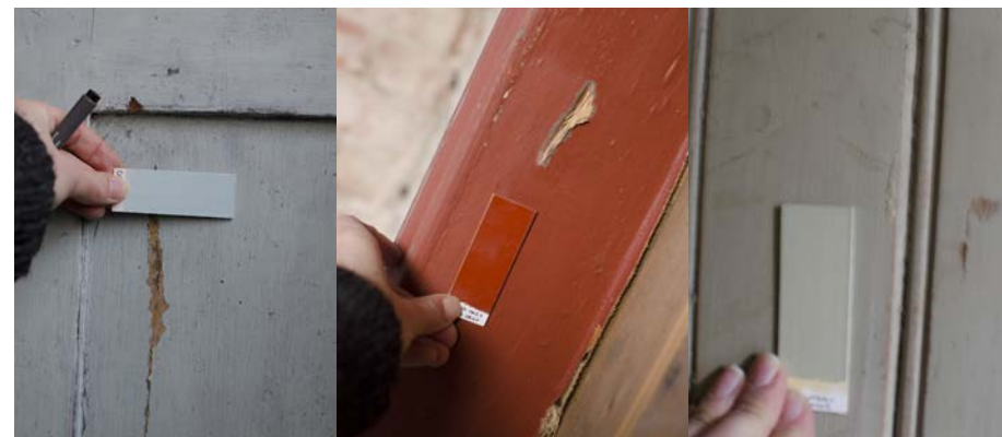
Testing av egne oppstrøk mot eksisterende flater.
