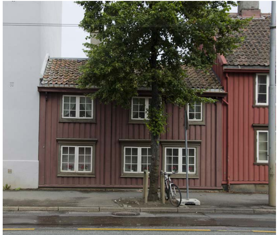
Kongensgate 82, Trondheim (1720-årene). Større vinduer og andre etasje lagt til senere på 1700-tallet.
