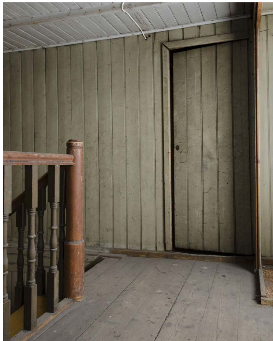
Bakkegata 1A, Trondheim. Trapperom i bakgårdsbygning, 3. etasje.
