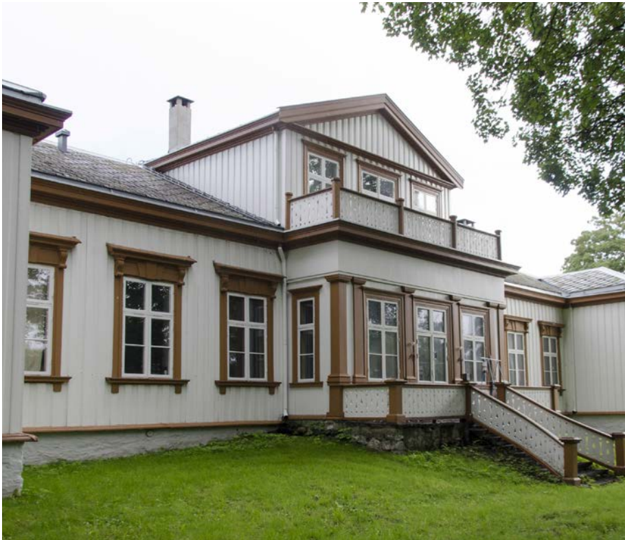
Devle gård, Trondheim (1827-1828, ombygd 1840).
