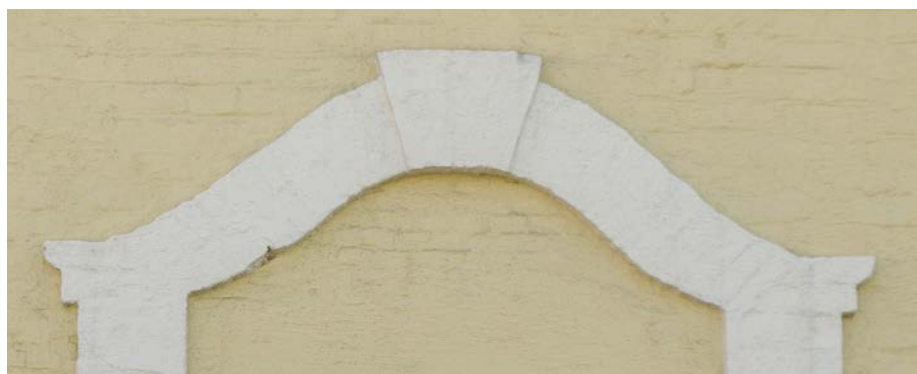
Sukkerhuset, Trondheim (1754). Detalj over vindu.
