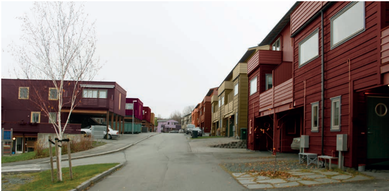
Inne på boligfeltets overside, sett fra vest til øst. De kulørte rekkene gir stor variasjon i ellers grå, høstlige omgivelser. Huset i bakkant (D1), fremstår som litt for lys i en ellers mørkere fargepalett.
