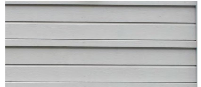
Lektepanel med kledning med fals
