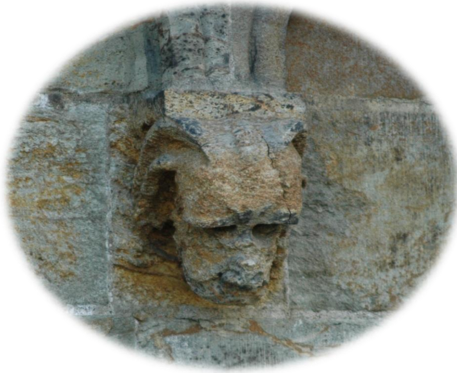
Figur 7. Forvitret korsoll, Korets nordre fasade. (Foto: Ronald Hübner).
