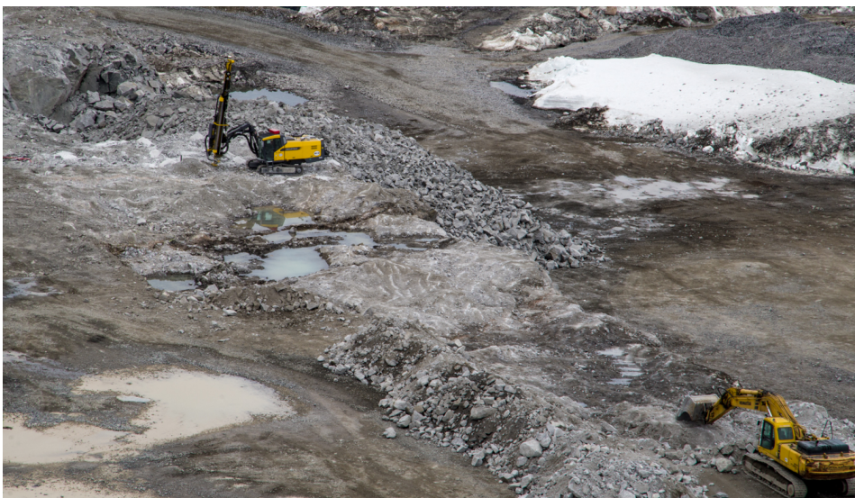
Figur 5.5: Kartlagt område i dagbruddet. Området mellom boreriggen og gravemaskinen som er rensket, det kan sees at det er relativt mye grus igjen etter rensk.
