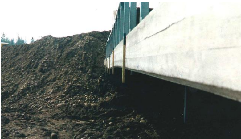
Figur 39: Måling av nedbøyning til kantbjelken på sydsiden
