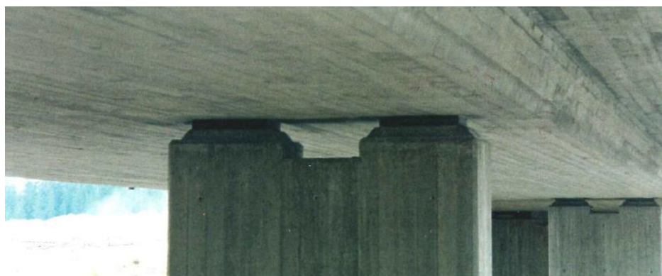
Figur 29: Nærbilde av søyleopplegg med to neoprene blokkklager.
