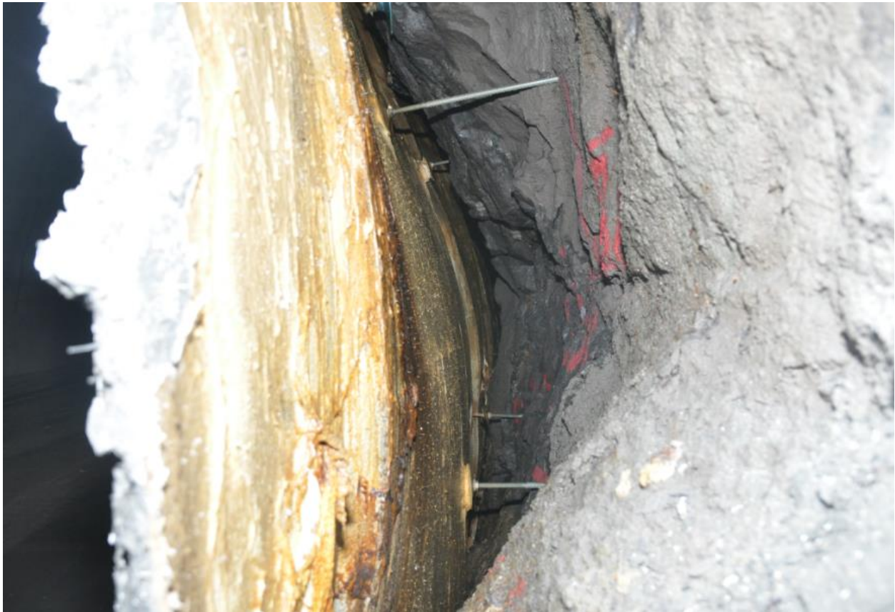
Figur 7.20 Et skall av sprøytebetong med påklistret, smeltet PE-skum (fotograf: Petter Hole)
